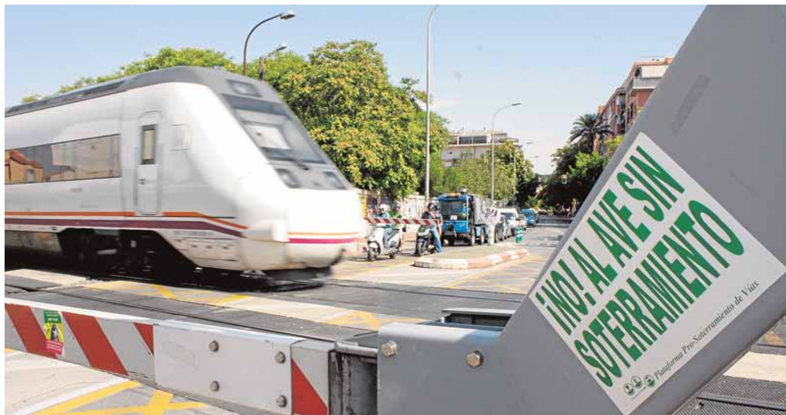
Un Talgo atravesando el paso a nivel de Santiago el Mayor, epicentro del movimiento vecinal que exige el soterramiento. :: JUAN CARLOS CAVAL
