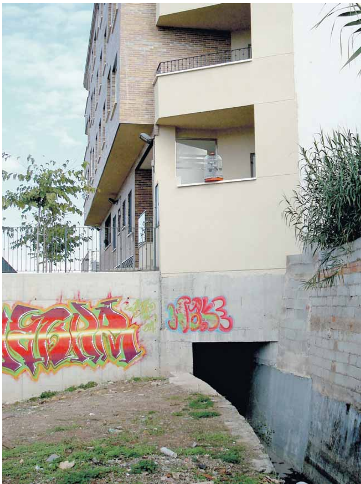
Edificio en la pedanía de Santo Ángel, construido encima del cauce de la acequia de Beniaján. ■ HUERMUR
