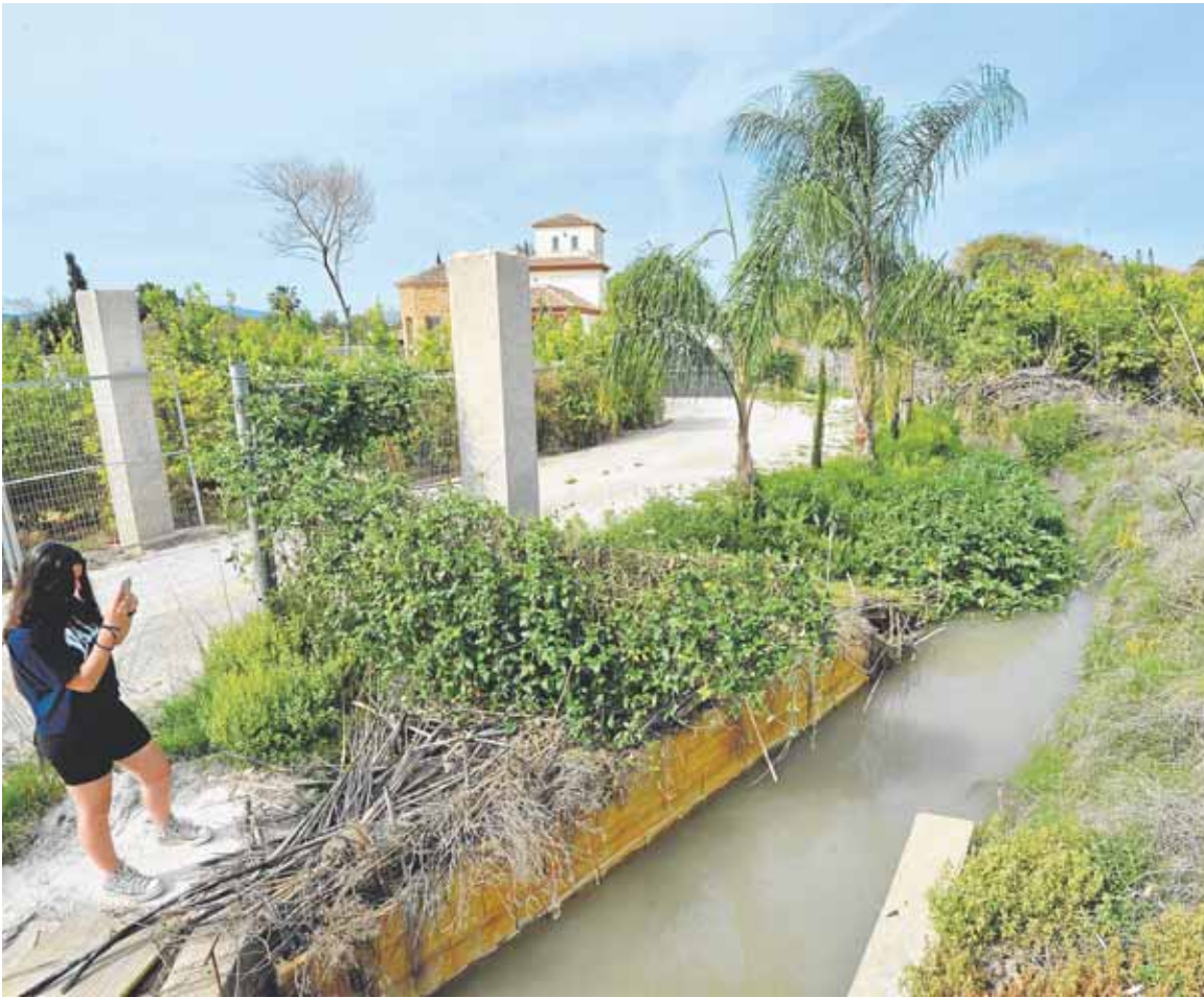
Un tramo de la acequia Alfatego que discurre a cielo abierto a su paso por Rincón de Beniscornia. VICENTE VICÉNS / AGM
